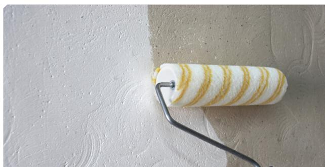
■ Imprimación del soporte con FIJAPREN AL DISOLVENTE
